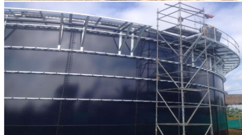
TANQUE TUBARÁ – ATLANTICO
