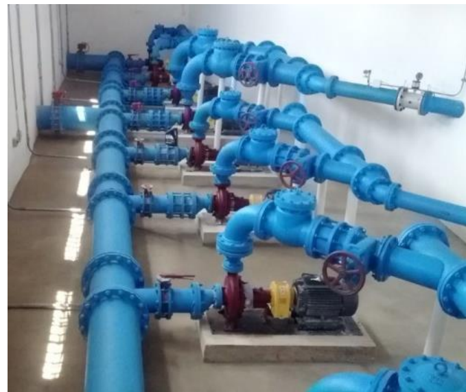
OPTIMIZACIÓN ACUEDUCTO SAHAGÚN - CORDOBA 48 MIL BENEFICIADOS
